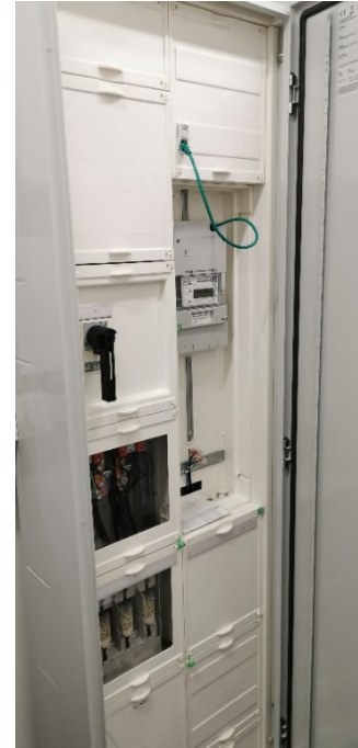
Abbildung 9 Unterverteilung Batteriespeicher
