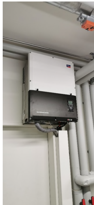
Abbildung 25 Batteriewechselrichter
