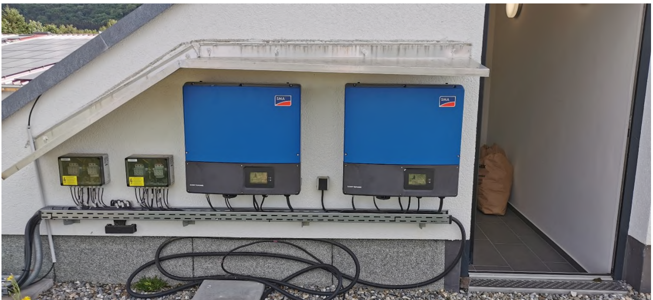
Abbildung 4 Wechselrichter SMA
