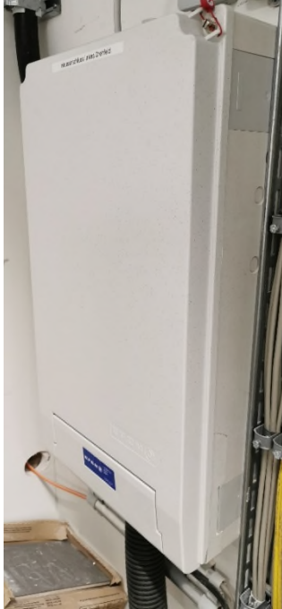
Abbildung 5 Hausanschlusskasten
