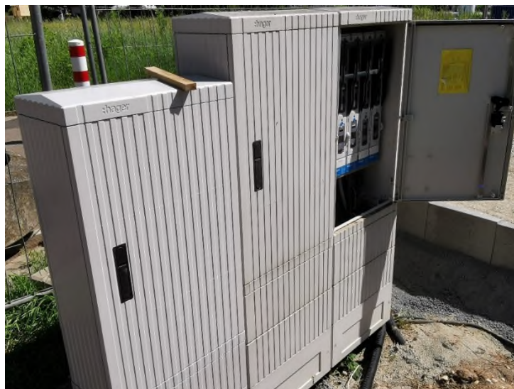
Abbildung 11 Außenverteiler
